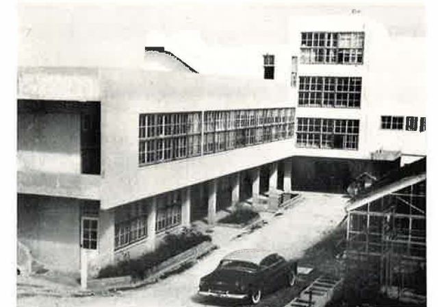
農家政工学ビル Agricultural Building
